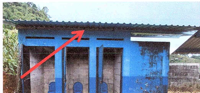
Foto 2: Se realizó el cambio de entechado de los nueve servicios sanitarios mejorando así las condiciones para su uso.
