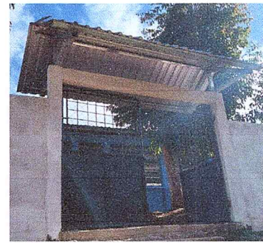
Foto 10: Se tiene una mayor visibilidad del portón y sobre todo una mejor estructura metálica, para la protección del mismo.
