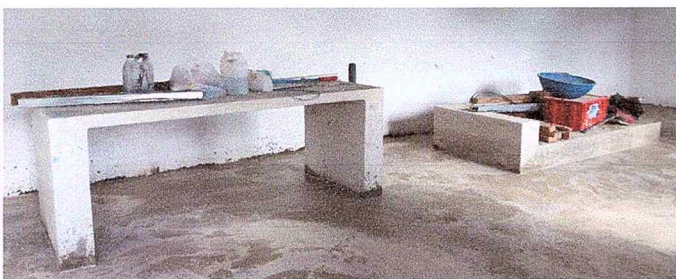
Foto 11: Se modificó la estructura de la estufa y se añadió una mesa de concreto, para la preparación de los alimentos, un espacio más amplio y accesible para todos.
