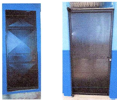
Foto 4: Se aplicó pintura anticorrosiva a las diez (10) puertas de los salones de clases, para una mejor visibilidad.
