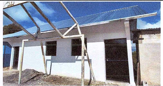
Foto 12: Se sustituyeron dos puertas y dos ventanas del lugar que ocupan para la cocina, para que sean de larga duración y sobre todo por el ambiente tan húmedo del área.
