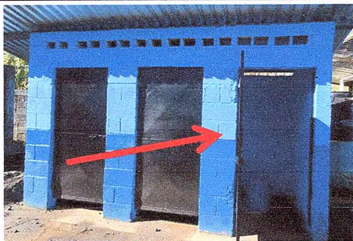
Foto 3: Se realizó el mantenimiento, reparación y pintura de las puertas de los nueve (9) sanitarios, ahora podrán ser utilizados por los estudiantes sin ningún inconveniente.
