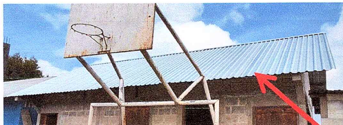
Foto 1: Se ha realizado el cambio del entechado en área de cocina. Se aplicó pintura anticorrosiva en la estructura de techo, porque se encontraba en buenas condiciones aún.
